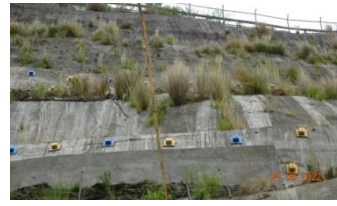
Cables Anchors
