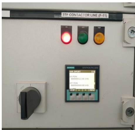
Fig 2- sentron pacmeter 3200
